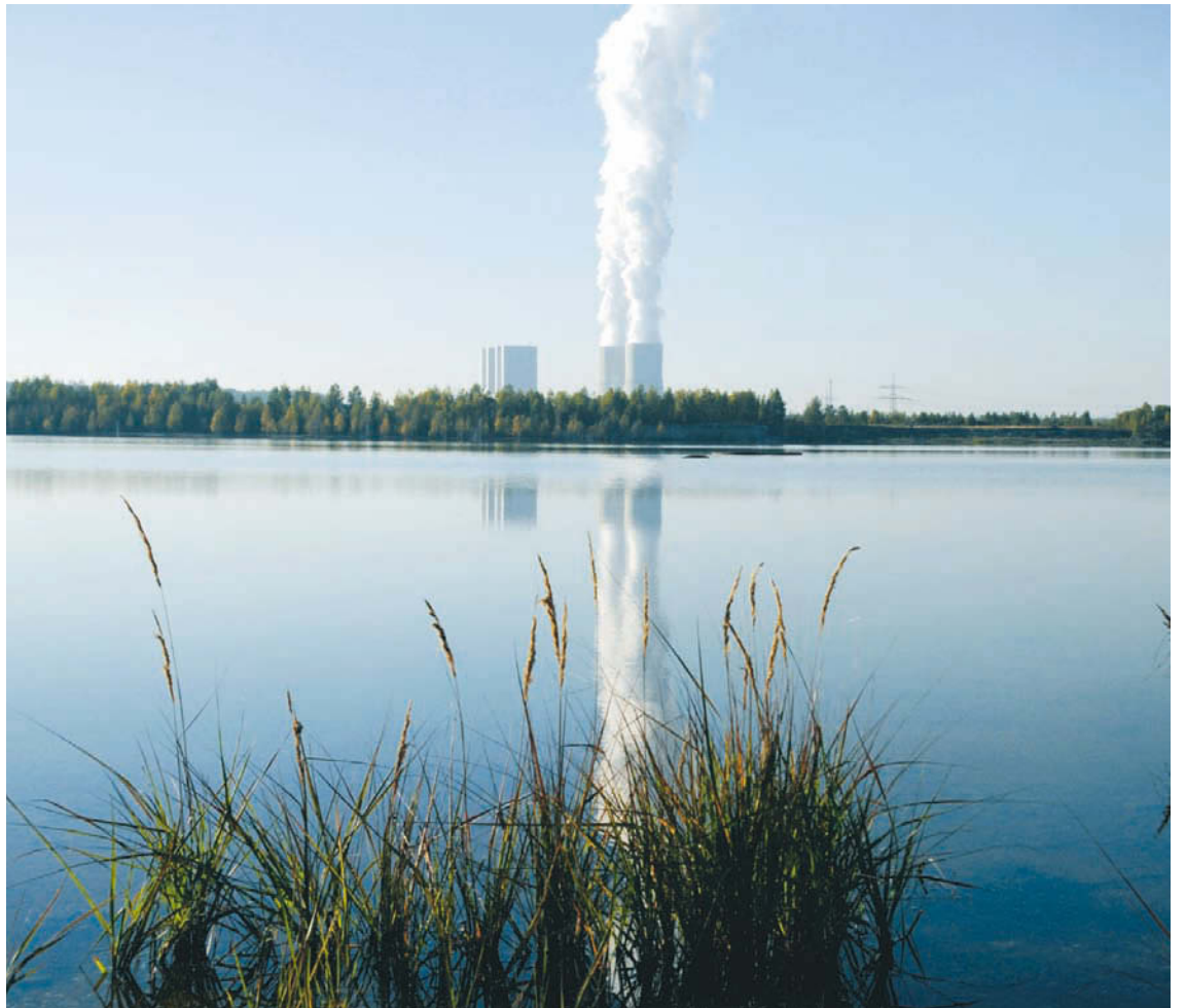
KOLKRAFT. Vattenfalls pressbild av kolkraftverket Lippendorf i Sachsen, Tyskland.
