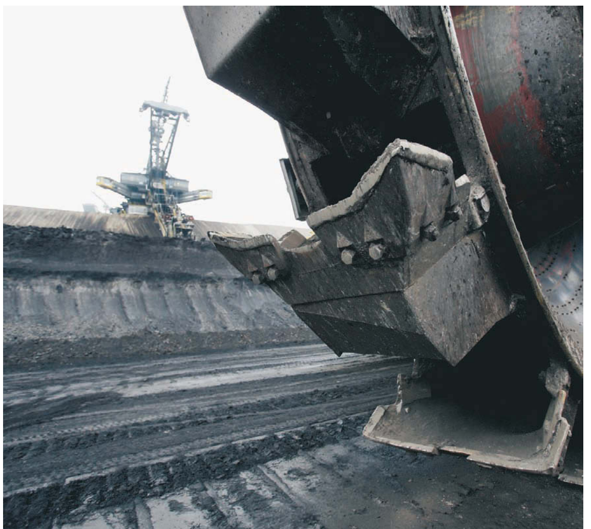
KOLKRAFT. En journalists bild av Vattenfalls dagbrott i Jaenschwalde i östra Tyskland.
